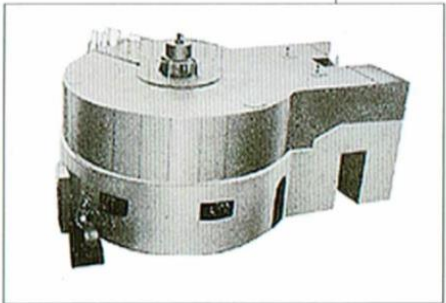
1941年：神戸製作所 国産第一号のかさ形水車発電機完成
