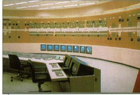
1985年：制御製作所 関越トンネル(延長11km日本最長)に遠方監視制御及び換気制御システムを納入。トンネル内火災時の二次災害を防止する技術として、世界で初めて火災時風速零化制御を導入
