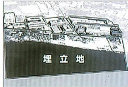
1962年：神戸製作所 神戸埋め立て工事完了
