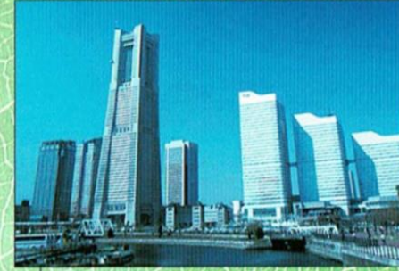
1993年：制御製作所 当社の超大規模ビル管理システムを納入したランドマークタワー竣工(延床面積39万㎡、監視点数7万点)
